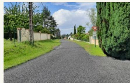
L'entreprise COLAS est intervenue également sur le terrain à l'arrière de Centramalice pour la réalisation d'un cheminement PMR voué à l'évacuation d'urgence des personnes à mobilité réduite. Ce chemin en calcaire de 1,50 m de large sort rue des Peupliers.
